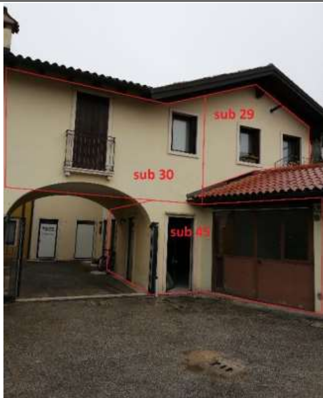
PT – Corte comune (sub 10) Foto 3: vista esterna fabbricato
