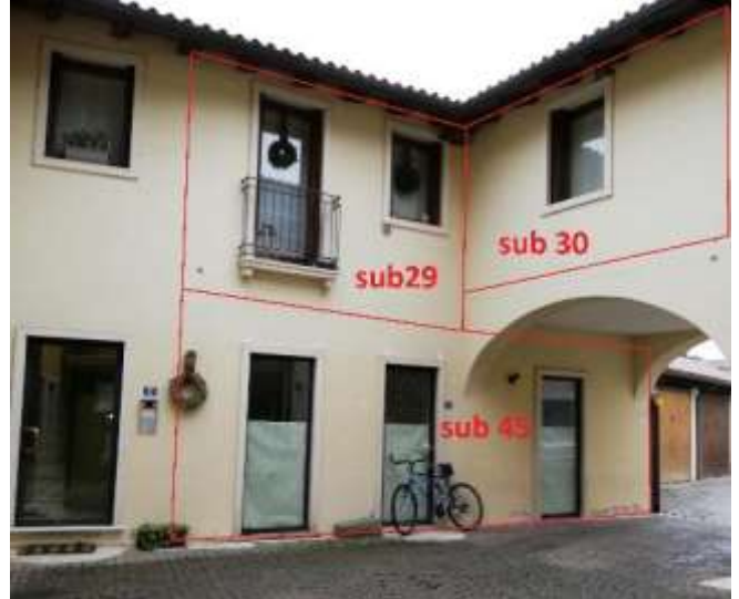
PT – Corte comune (sub 10) Foto 2: vista esterna fabbricato
