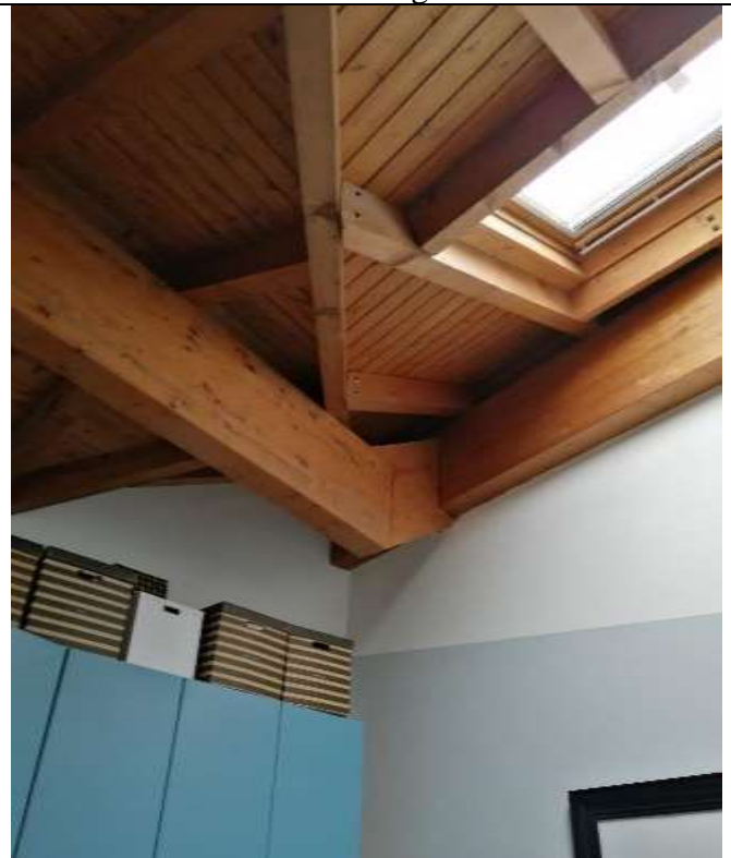
Appartamento sub 29 – P1 Foto 8: soffitto con travi a vista
